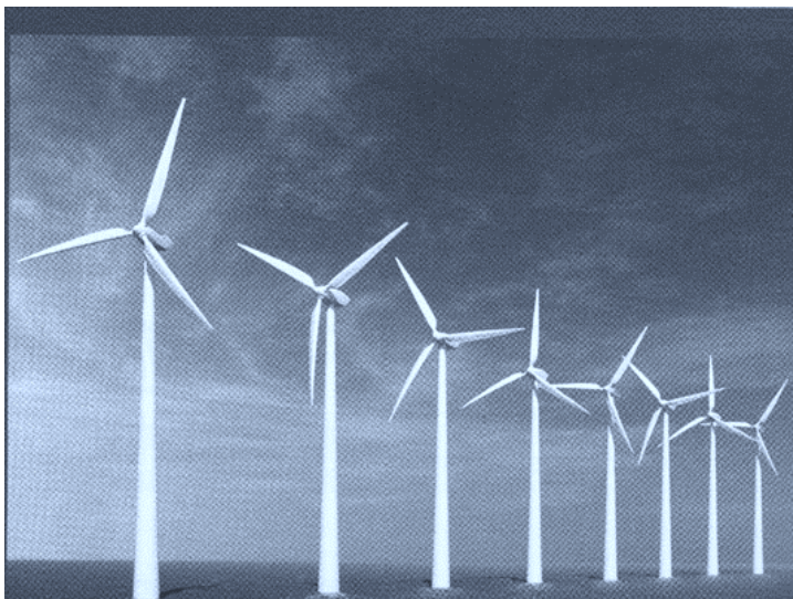
Рисунок 6.11 – Ветро-электростанция со стойками и лопастями изготовленными из полимерных композитов
