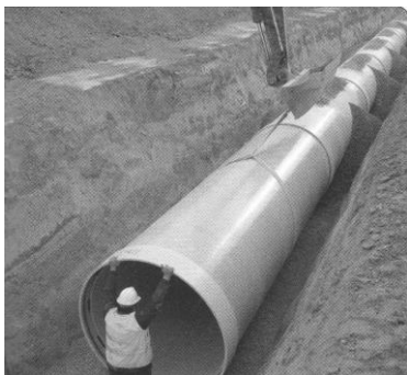
Рисунок 6.18 – Укладка в Турции трубопровода из стеклопластиковых труб
