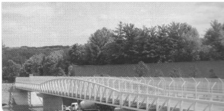
Рисунок 6.13 – Мост из стеклопластика. Выполнен из панелей 2,5×4,7 м
