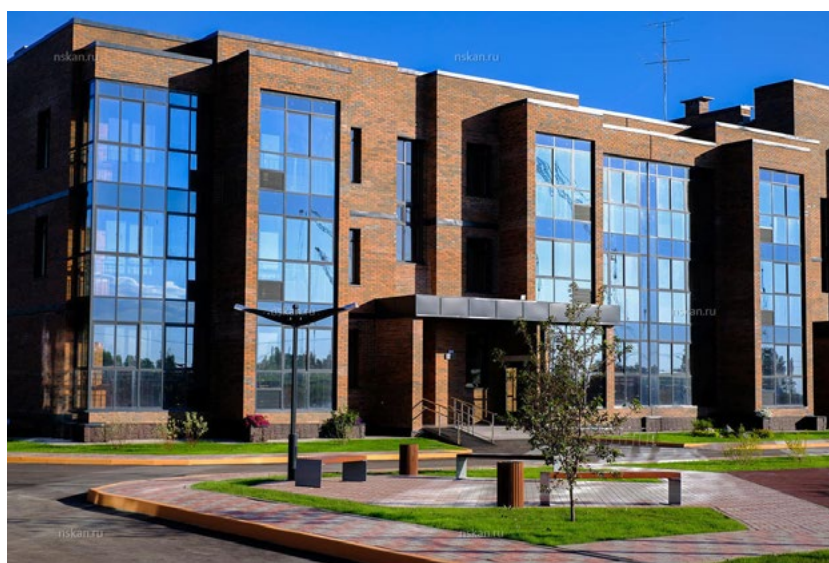
Рис. 124 – Остекление и открытая кирпичная кладка в отделке фасадов [44].
