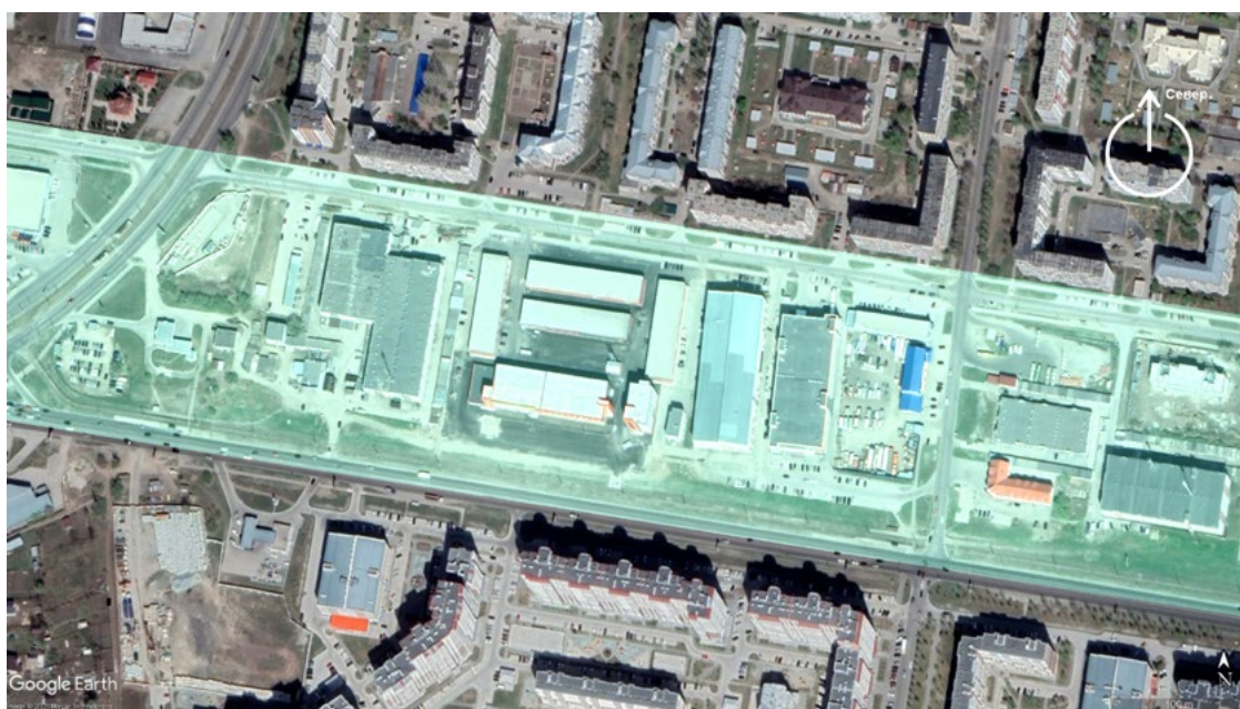
Рис. 39 – Полоса нежилых микрорайонов с многоуровневыми автостоянками вдоль ул. Власихинской в г. Барнауле.
