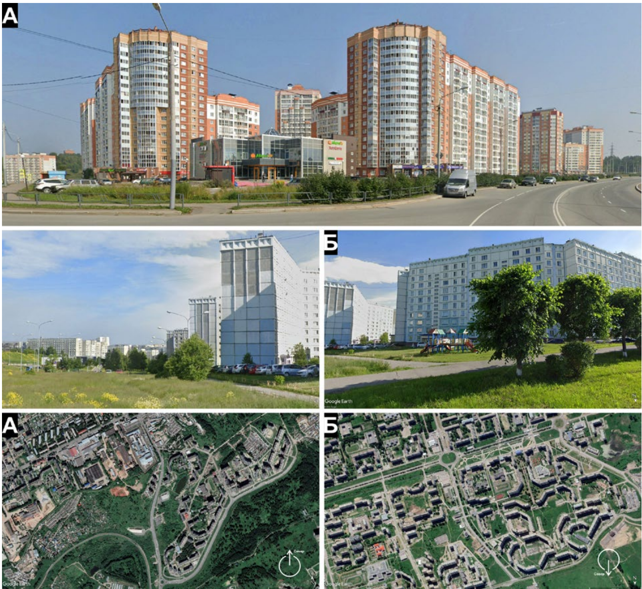
Рис. 70 – Морфотипы микрорайонной застройки (аэрофотосъёмка и наземные виды). А – г. Томск, Октябрьский р-н, ул. Обручева; Б – г. Новокузнецк, Новоильинский р-н, ул. Рокоссовского – Чернышова.
