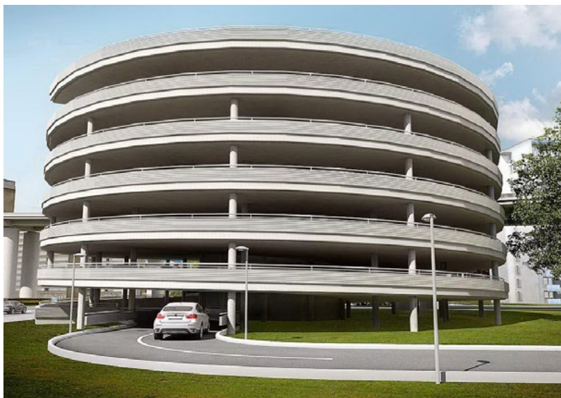
Рис. 102 – Многоуровневая автостоянка вокруг спиралевидной рампы [96].
