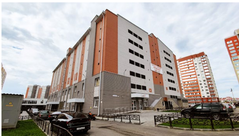
Рис. 103 – Закрытая многоуровневая автостоянка, г. Барнаул [81].
