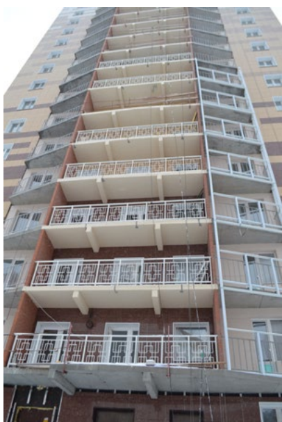
Рис. 92 – Незадымляемая лестничная клетка типа Н1 на фасаде [78].
