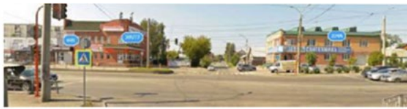
Рисунок 21 – Вид пересечения ул. Челюскинцев и ул. Партизанской с западной стороны
