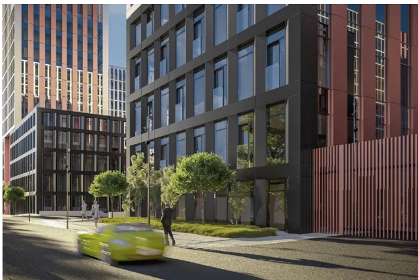
Рис. 125 – Алюминиевые панели в отделке фасадов [95].
