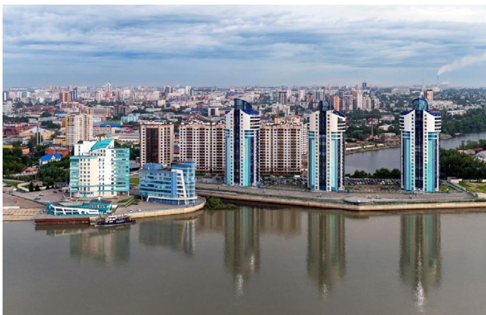
Рис. 114 – ЖК, комплекс точечной застройки «Аквамарин», г. Барнаул [49].
