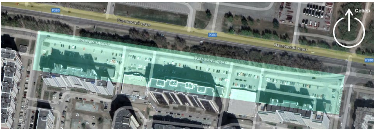
Рис. 49 – Наземные парковки у встроенно-пристроенного стилобата на периферии микрорайона у Павловского тракта, г. Барнаул.
