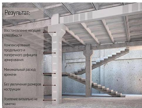
Рисунок 4.7 – Результаты использования композитных накладок для упрочнения бетонных строительных конструкций
