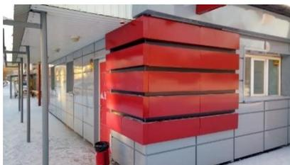
Рисунок 2.2 – Композитные панели для вентилируемых фасадов
