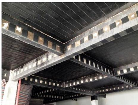
Рисунок 4.8 – Подкрепление бетонных конструкций углепластиковыми накладками
