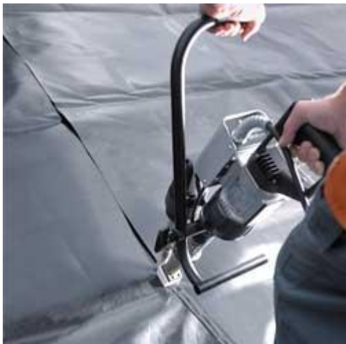
Рисунок 3 – Экструзионная сварка листов мембраны внахлест
