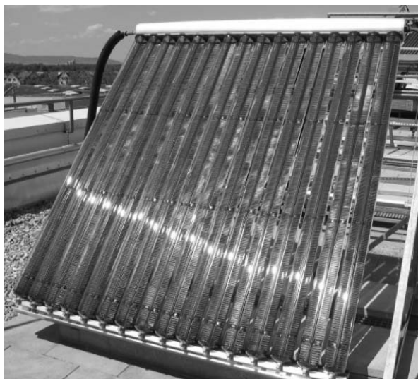
Рисунок 1 – Солнечный коллектор Seido 1-16
