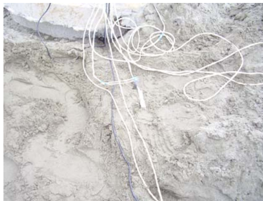
Рис. 4. Установка тензометрических датчиков
