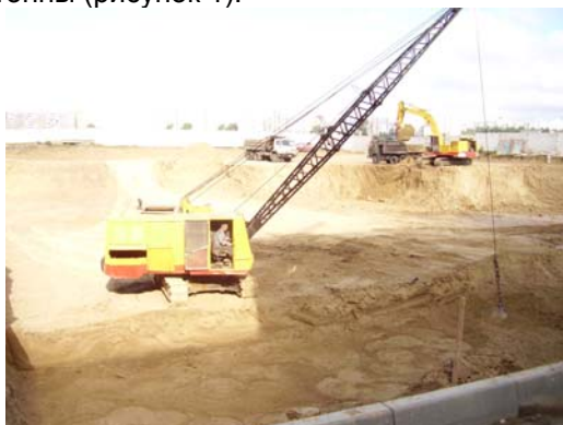
Рис. 1. Уплотнение лессового основания перед устройством подушки
