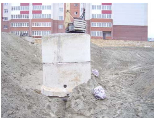
Рис. 2. Колодец для наблюдения за основанием
