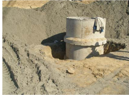
Рис. 9. Укладка песчаной подушки вокруг колодца
