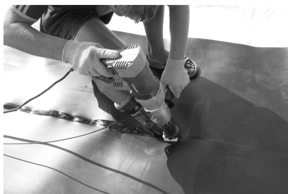
Рисунок 1 – Экструзионная сварка полиэтиленового листа марки ПЭНД
