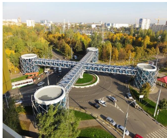
Рисунок 4 – Надземный пешеходный переход в г. Химки
