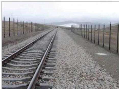
Рисунок 7 – Термостабилизация насыпи железнодорожного полотна
