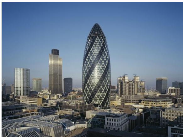
Рисунок 2 – Здание 30 St Mary Axe, в Лондоне
