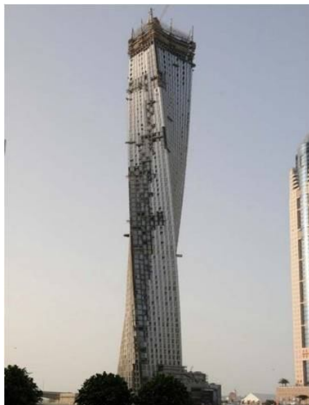
Рисунок 9 – Башня Dubai 'S' Infinity Tower, ОАЭ
