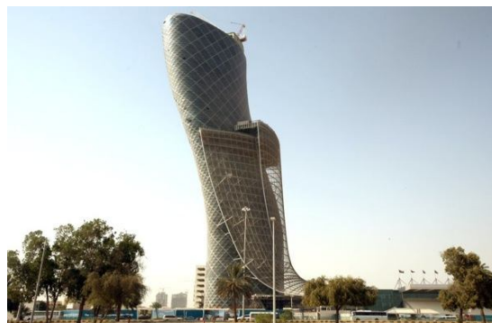
Рисунок 8 – Здание Capital Gate Abu Dhabi, архитектурное бюро RMJM London, 2010 г.
