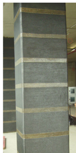
Рисунок 2 – Усиление железобетонной колонны фиброармированными пластиками
