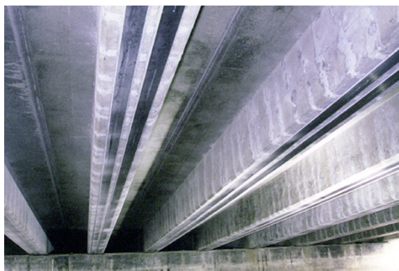
Рисунок 3 – Усиление мостовых балок фиброармированными пластиками
