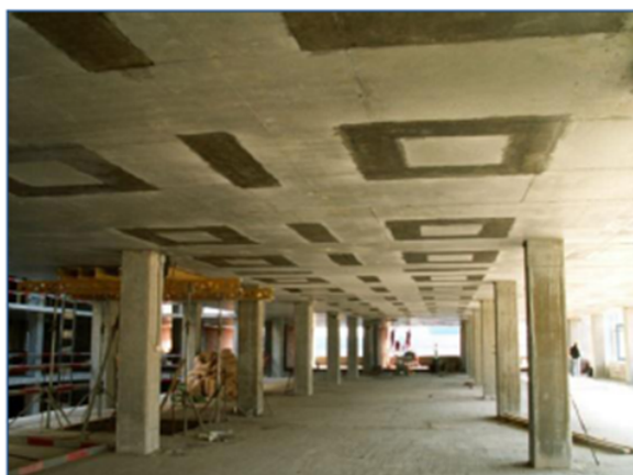
Рисунок 1 – Усиление железобетонного перекрытия фиброармированными пластиками
