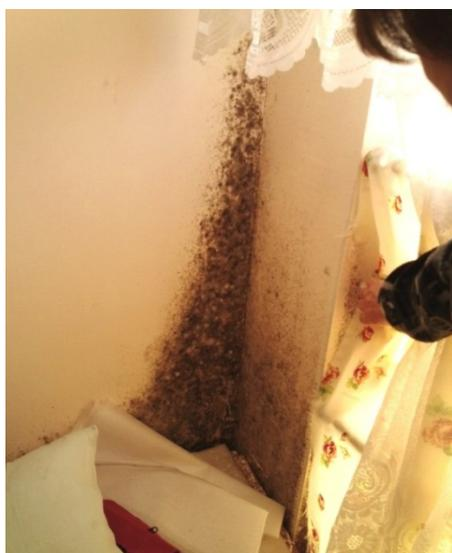
Рисунок 6 – Поражение стен грибком
