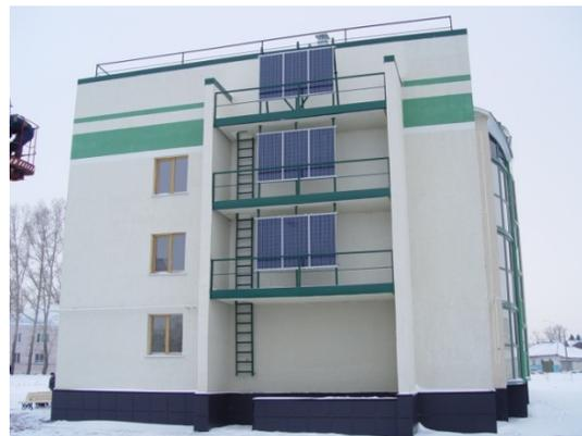
Рисунок 3 – Солнечные модули на торце здания
