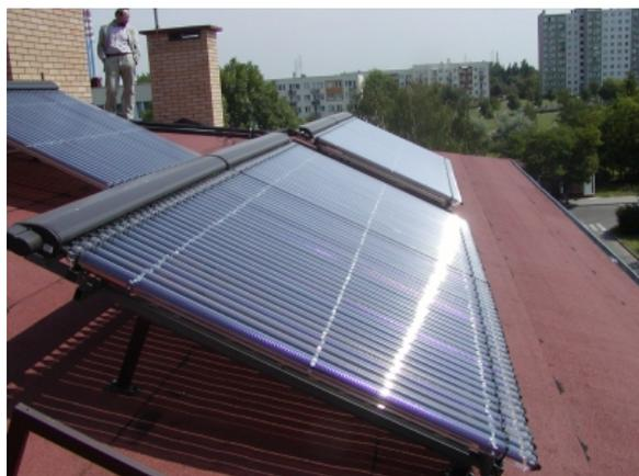
Рисунок 2 – Солнечные жидкостные коллекторы на крыше
