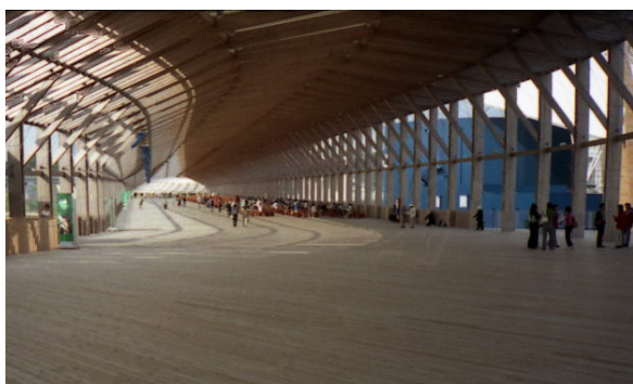
Рисунок 4 – Высокотехнологичный переход из традиционных и композитных материалов, EXPO 2005, Нагоя. Фото автора
