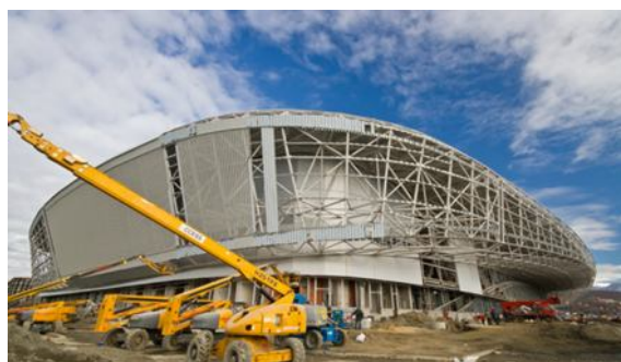
Рисунок 4 – Фасадная система конькобежного центра «Адлер-Арена»
