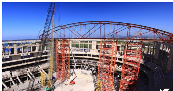
Рисунок 1 – Стальная ферма в покрытии ледового дворца «Большой»
