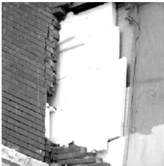
Рисунок 3 – Наружная стена с обрушившимся лицевым слоем
