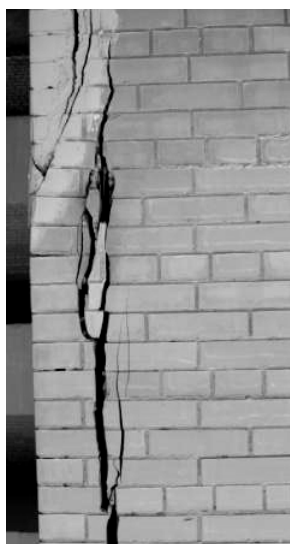
Рисунок 1 – Вертикальная трещина в лицевом слое кладки трехслойной наружной стены
