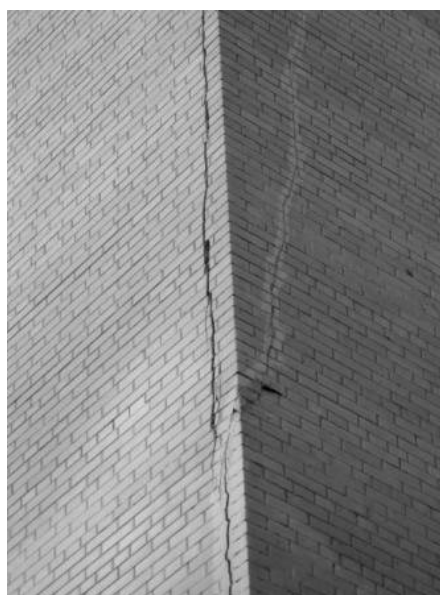
Рисунок 2 – Отслоение кладки лицевого слоя
