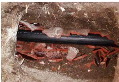
Рисунок 2 – Вид общий фрагмента использования метода «труба в трубу – с разрушением»
