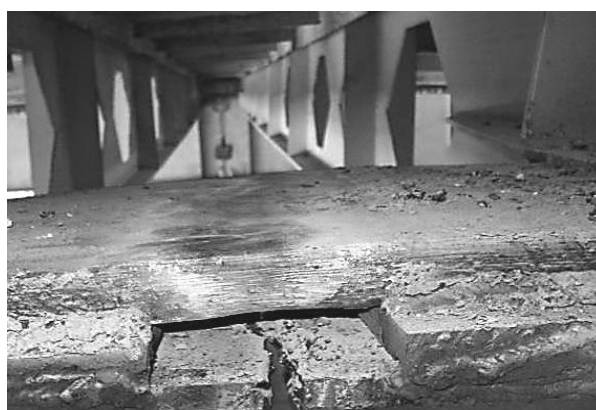
Рисунок 2 - Монтажное соединение неразрезной балки посредством накладок на средней колонне. Разрезка газом нижней накладки и расхождение стыка реза после нагрева верхней накладки
