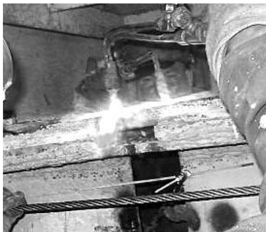
Рисунок 5 - Нагрев газовыми горелками верхней пластины в коньковом узле
