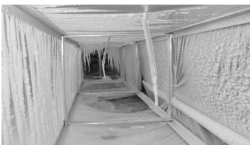
Рисунок 5 – Нарастание слоя льда на стенках канала
