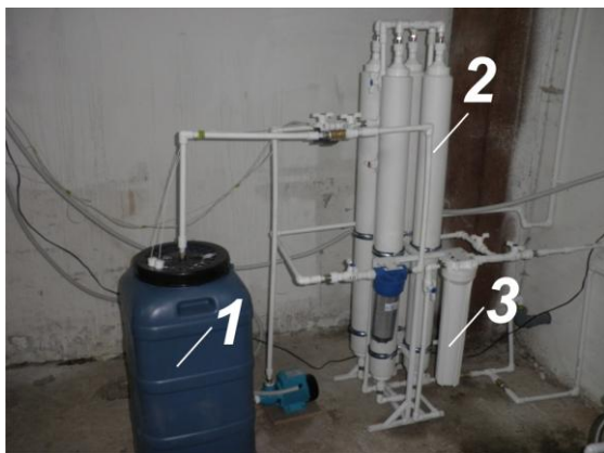
Рисунок 3 – Установка очистки воды «Алтай» 1 – аэратор, 2 – фильтр-обезжелезиватели, 3 – модуль с «Бентосорбом»
