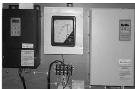
Рисунок 10 – Модуль преобразователей частоты
