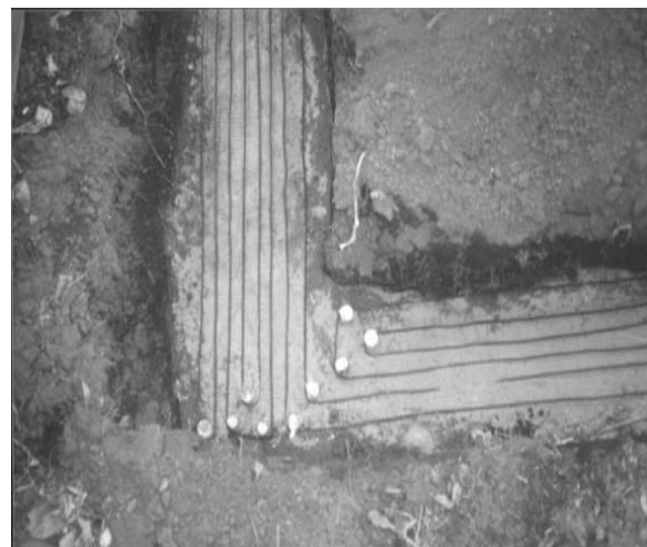
Рисунок 4-Схема укладки кабеля для обогрева почвы в теплице:
