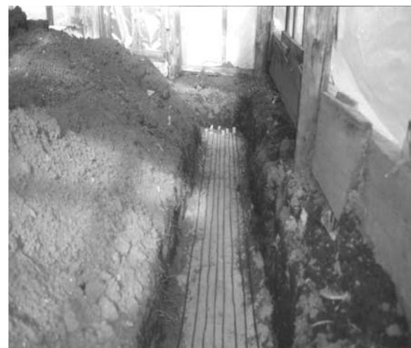
Рисунок 5-Общий вид греющего кабеля в траншее
