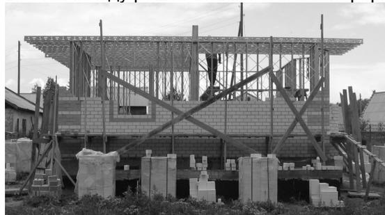
Рисунок 3 – Выступающие за грань стены междуэтажные балки
