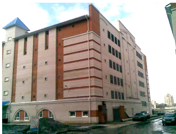
Рисунок 3 – Возведение последнего этажа здания
