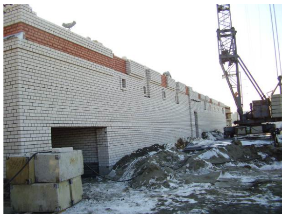
Рисунок 2 – Возведение первого этажа здания
