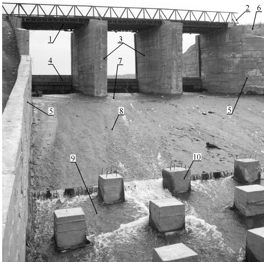
Рисунок 3 – Вид на бетонные водосбросные сооружения земляной плотины со стороны нижнего бьефа МикроГЭС на реке Ташта Красногорского района Алтайского края:
