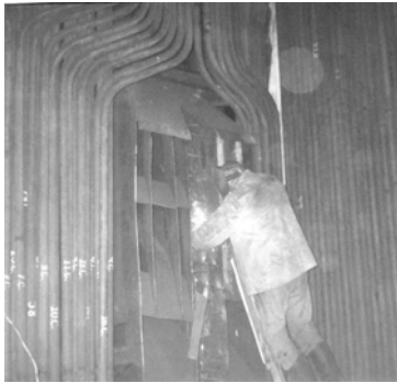
Рис.7. Монтаж V-образных горелок котла ЭЧМ-60
