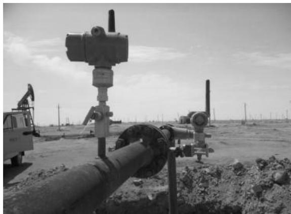
Рисунок 2 – Узлы учёта на базе Rosemount3051S
