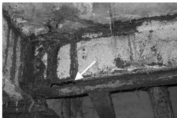
Рисунок 1 – Сквозная коррозия стенки балки
