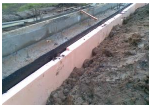
Рисунок 8 – Создание теплоизоляционного контура
