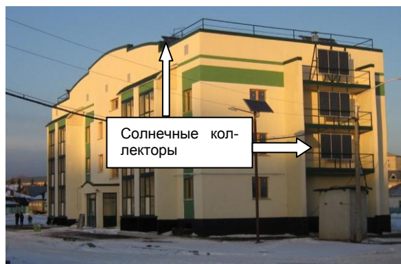
Рисунок 4 – Расположение солнечных коллекторов в жилом доме по ул. Смирнова, 67 в г. Барнауле
