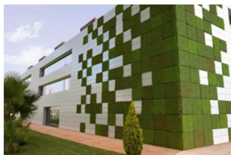
Рисунок 4 – Фасад здания с участками модульных зеленых стен, разработанный архитектором Эмилио Лобато
