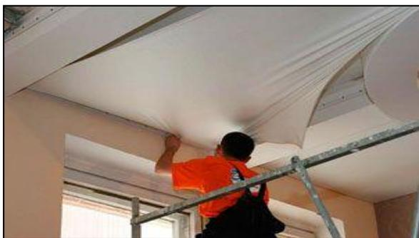
Рисунок 3 – Фрагмент технологической операции монтажа полотна натяжного потолка
