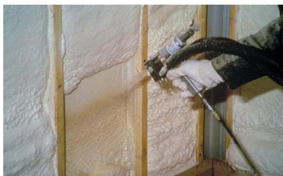
Рисунок 2 – Нанесение пенополиуретана с помощью пистолета-распылителя
