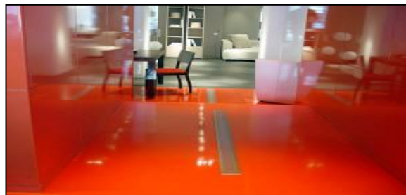
Рисунок 1 – Типовое покрытие в виде полиуретанового наливного пола в торгово-выставочном комплексе
