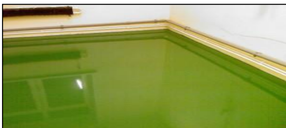
Рисунок 2 – Типовое покрытие в виде эпоксидного наливного пола в торговом-выставочном комплексе
