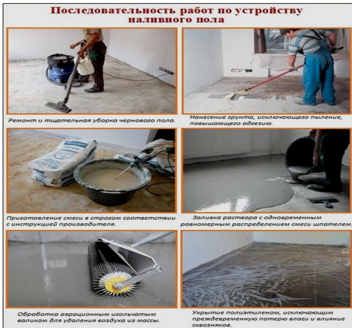
Рисунок 4 – Последовательность выполнения технологических операций по устройству наливных полов
