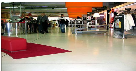
Рисунок 3 – Наливной пол с топпинговым покрытием в торговом-выставочном комплексе
