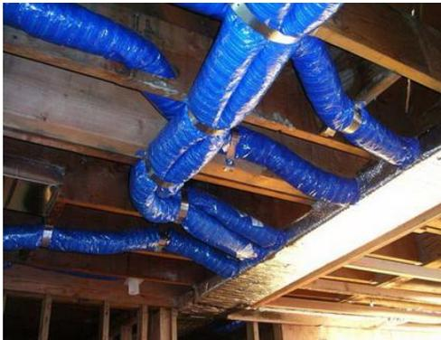
Рисунок 4 – Воздуховоды подвесного типа
