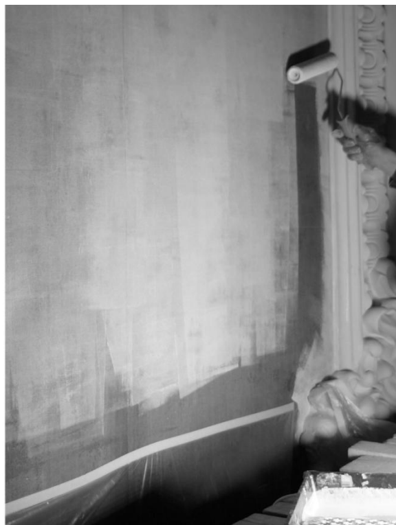
Илл. 18. Грунтовка холста акриловым грунтом. Наносятся два слоя
