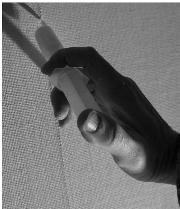
Илл. 19. Заделка швов стыковки холста подведением шпатлевки через шприц. Шлифовка грунтованной поверхности шлифовальной машиной
