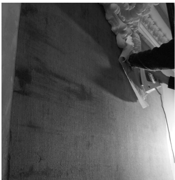
Илл. 17. Проглаживание наклеенного холста утюжком через фторопластовую пленку
