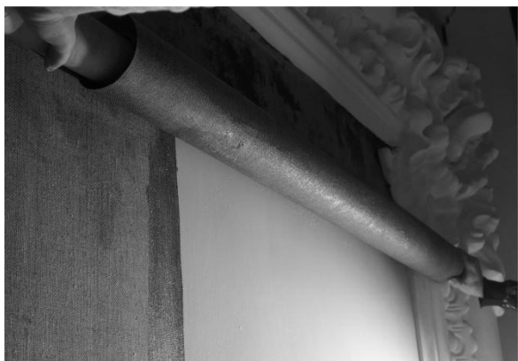
Илл. 16. Наклейка холста на стену раствором осетрового клея
