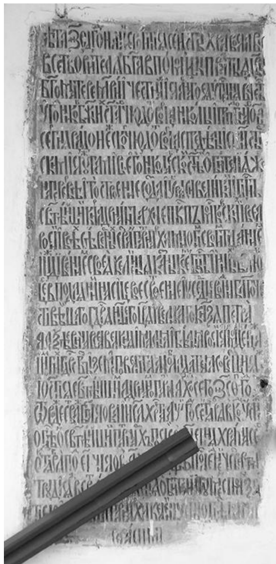
Илл. 3. Белокаменная плита со строительной надписью при входе в придельную церковь свт. Николая Чудотворца. Храм Успения Божией Матери, свт. Николая Чудотворца и прп. Сергия Радонежского. Северная стена. Николо-Перервинский монастырь. Москва. 25 октября 1700 года
