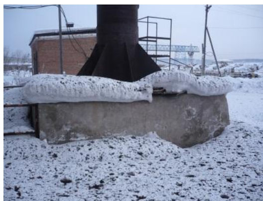
Рисунок 2 – Вынос несгоревшего топлива из дымовой трубы
