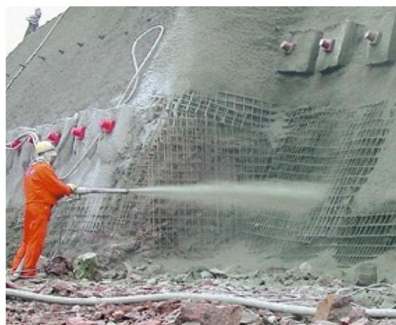
Рисунок 11 – Нанесение бетонной смеси при торкретировании
