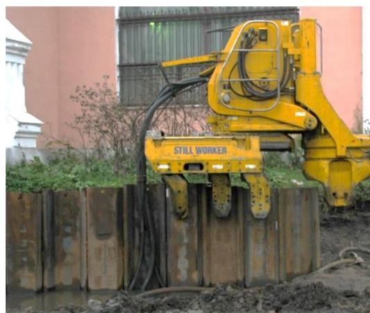
Рисунок 7 – Статическое вдавливание шпунта
