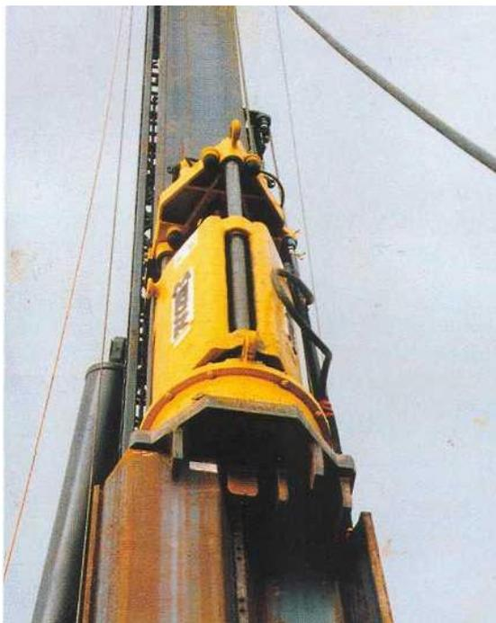
Рисунок 8 – Забивка шпунта трубчатым молотом
