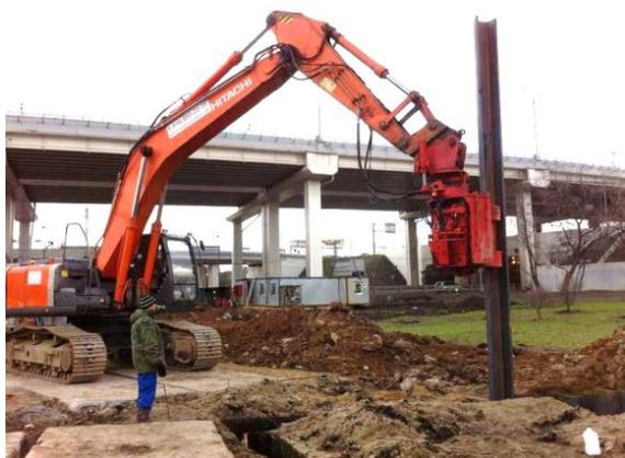
Рисунок 9 – Вибропогружение шпунта
