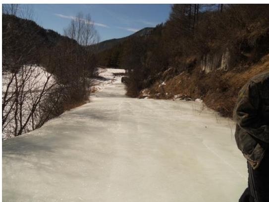
Рисунок 1 – Образование наледи от ключевых вод в зимний период
