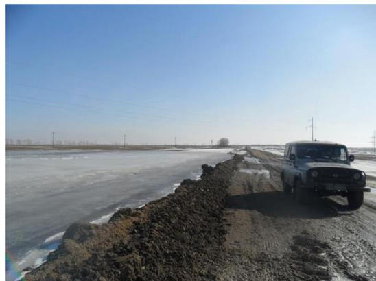
Рисунок 3 – Устройство грунтового вала из шлака вдоль участка наледообразования
