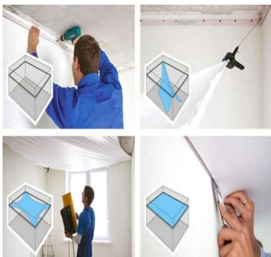
Рисунок 4 – Последовательность установки натяжных потолков по типовой технологии
