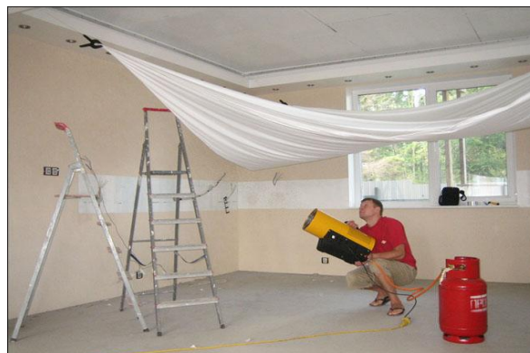
Рисунок 5 – Процесс прогрева полотна натяжного потолка тепловой пушкой
