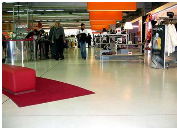
Рисунок 5 – Наливной бетонный пол с топпингом
