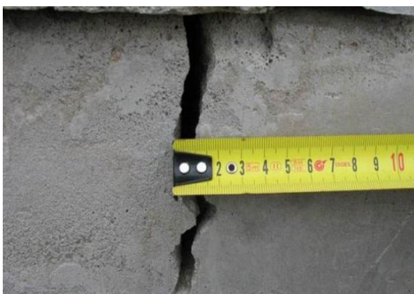
Рисунок 2 – Образование трещин в фундаменте в результате действия пучинистых сил
