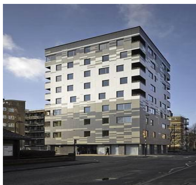
Рисунок 5 – 9-ти этажный жилой дом Stadthaus
