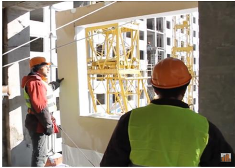
Рисунок 3 – Монтаж готовой стеновой панели
