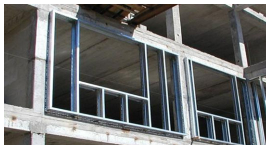
Рисунок 2 – Смонтированный каркас термопанели
