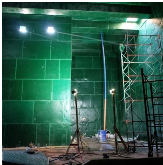
Рисунок 1 – Футеровка бетонной емкости полиэтиленовыми листами толщиной 4,0 мм
