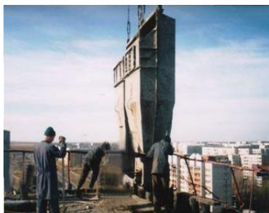
Рисунок 3 – Бетонирование наружных стен
