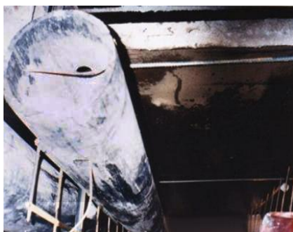
Рисунок 2 – Монтаж пустотообразователей и монтаж арматуры
