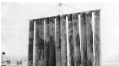
Рисунок 1 – Подача и демонтаж пустотообразователей производится краном с применением траверсы
