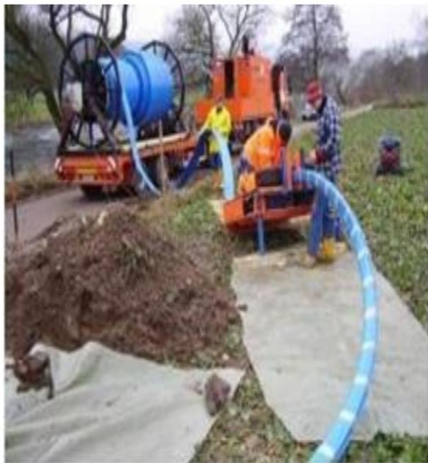
Рисунок 6 – Принципиальная схема установки «Примус Лайн»
