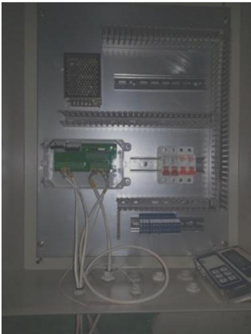
Рисунок 3 – Установка монтажной панели с окончательным вариантом компоновки оборудования в шкаф TDM IP54 (700×600×240)
